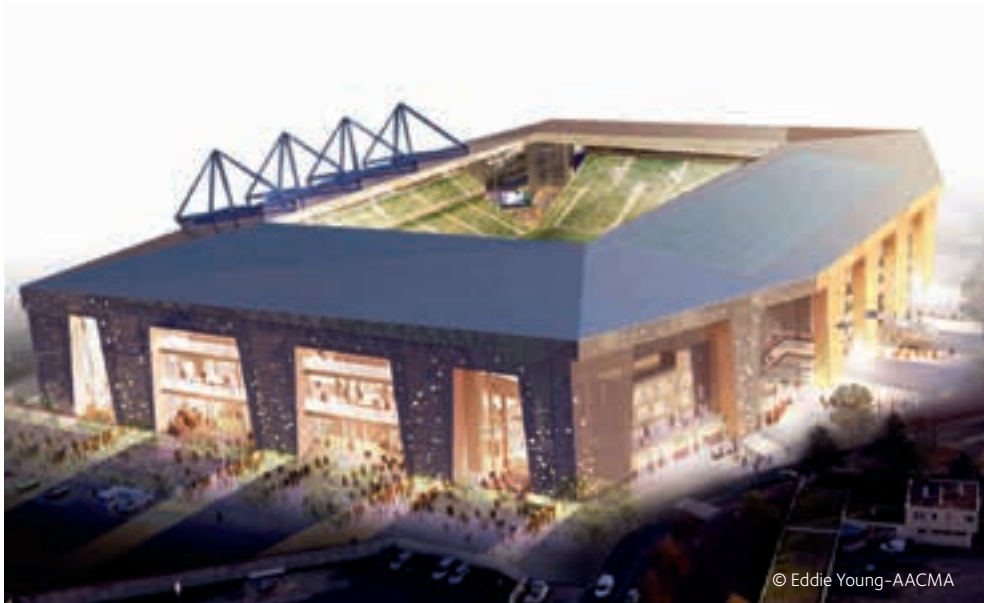
Le stade Geoffroy-Guichard de Saint-Étienne, visible jour et nuit grâce à son nouveau bardage en Aluzinc® Florelis.
