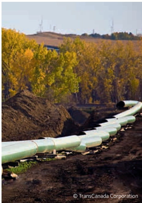
Gotowe do montażu elementy rurociągu Keystone firmy TransCanada.
