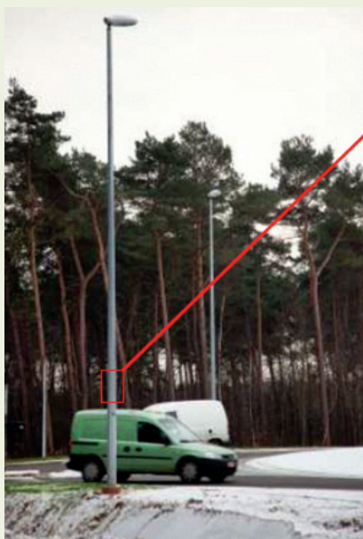
Latarnia ZIPpole® została zaprojektowana tak, by w przypadku uderzenia „rozpięła” się jak zamek błyskawiczny
