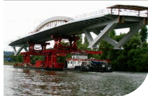
Transport środkowego przęsła mostu płaskodenną barką po Mozeli.
