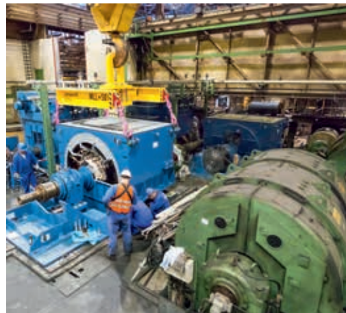
Montaż nowego silnika synchronicznego w walcowni posobnej taśm na zimno (po lewej) i stary silnik na prąd stały (po prawej)
