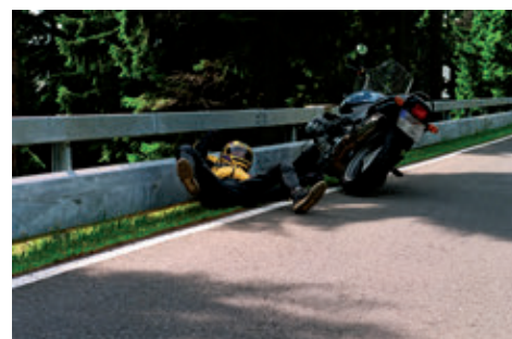
Figura 1: Exemplu de parapet rutier din oțel, fabricat din două părți, cu balustradă tradițională la partea superioară și sub-parapet suplimentar pentru protecția motocicliștilor (imagini prin amabilitatea Volkmann & Rossbach și PassCo)
