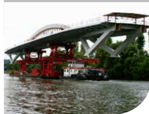
Transportul traveei centrale a podului cu barja pe râul Moselle.
