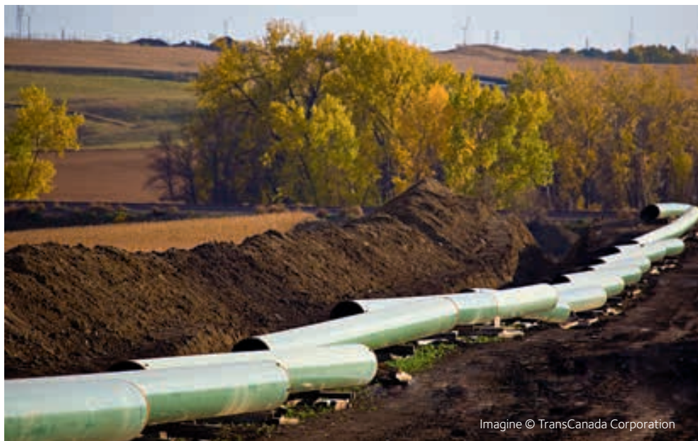
Țevi pentru conducta de petrol Keystone din cadrul TransCanada, pregătite pentru a fi poziționate.
