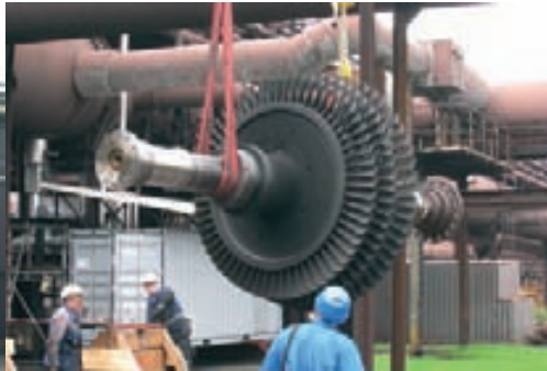
Preparando un rotor TRT para su instalación
