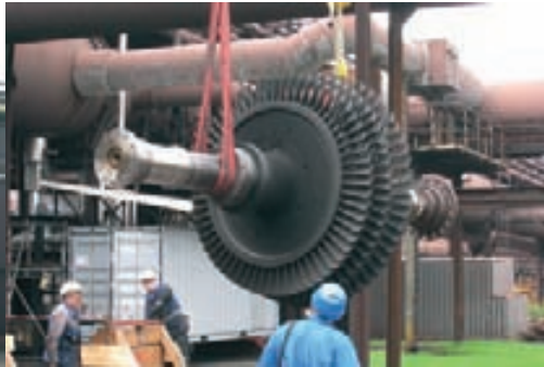
Rotor de TRT en cours de préparation pour l'installation.
