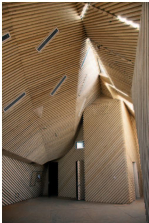
Dřevěné interiérové obklady spočívají na ocelových rámech
