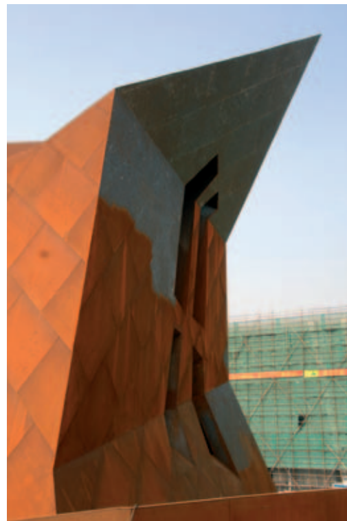
Patinující ocel exteriéru prochází oxidací
