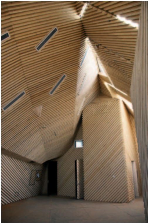
De houten panelen aan de binnenkant worden op hun plaats gehouden door stalen frames
