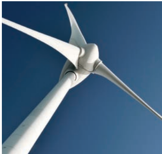
Větrná turbína s ocelovým stožárem
